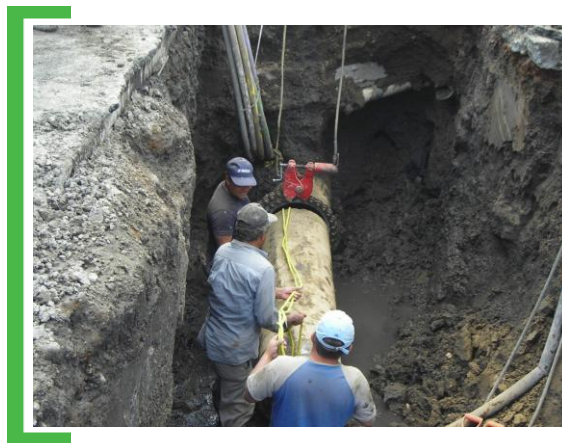
Imagen 3.2: Rehabilitación y sustitución de redes primarias
