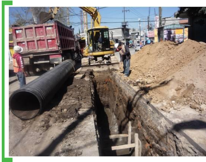
Imagen 3.5: Construcción de colectores
