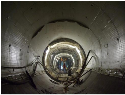
Imagen 3.4: Rehabilitación del emisor central del drenaje profundo
