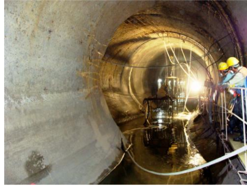
Imagen 3.4: Rehabilitación del emisor central del drenaje profundo
