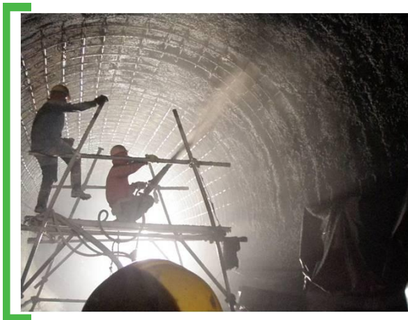
Imagen 3.3: Rehabilitación del Sistema de Drenaje Profundo
