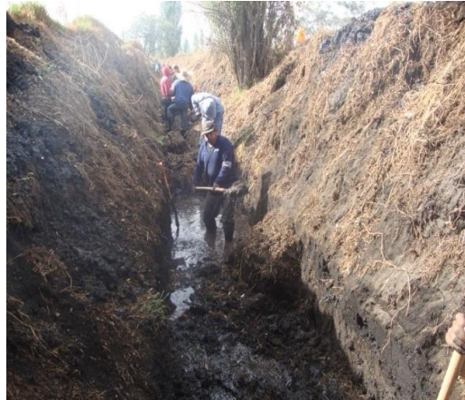
Imagen 1.24: Limpieza y desazolve de canales en Xochimilco
