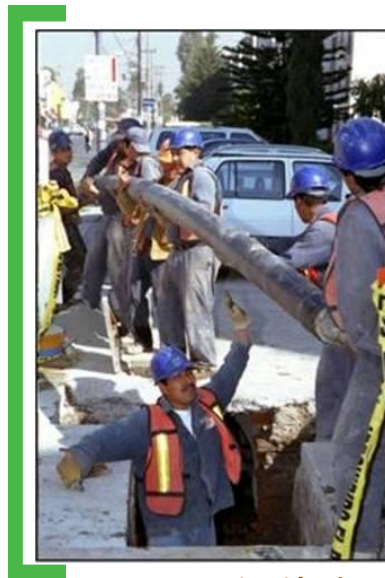
Imagen 3.1: Sustitución de tuberías
