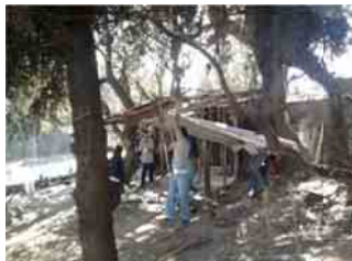
Desmantelamiento de viviendas, Suelo de Conservación Poblado de San Miguel Topilejo, Delegación Tlalpan
