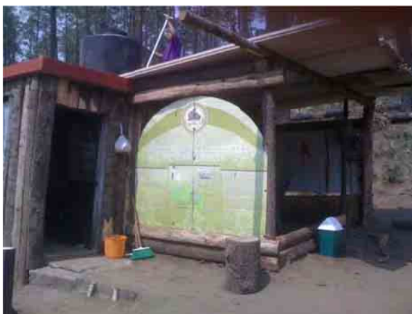
Caseta de vigilancia en la REC San Miguel Topilejo. Esta infraestructura ha ayudado a disminuir los ilícitos ambientales en el ANP
