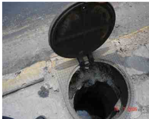
Alcantarillado azolvado por grasa
