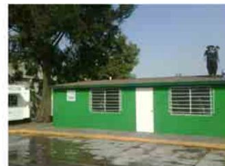
Trabajos de mantenimiento C10
